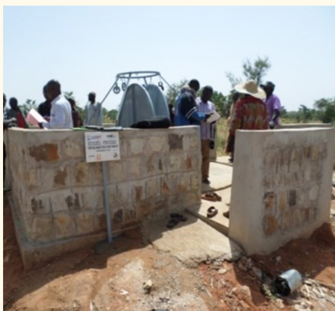
Puits moderne réhabilité à Nounou (cercle de Bandiagara)
